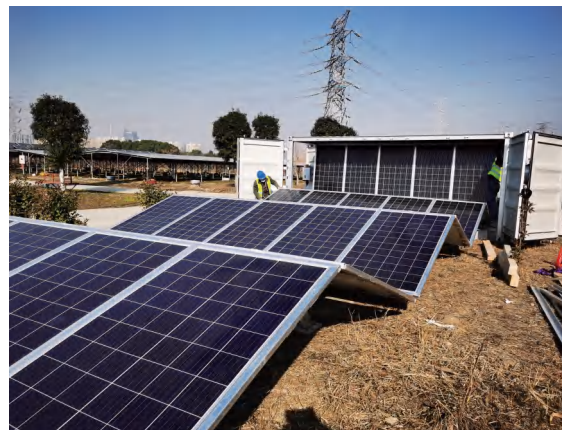
④ 展开光伏阵列 Unfold Solar PV Array
