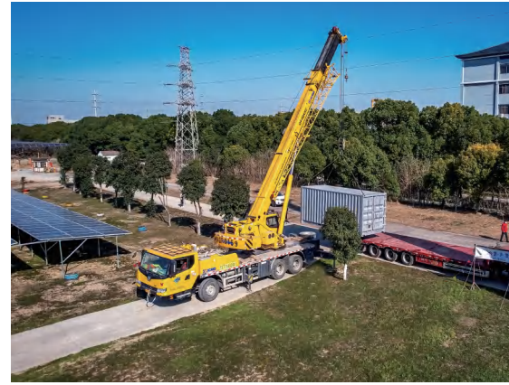
② 吊装就位 Hoisting in Position
