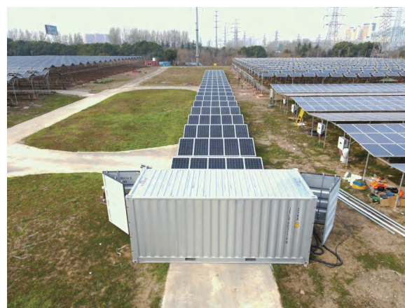
⑤ 电气接线安装 Cable Installation
